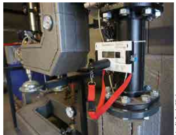
Wärmezähler eines Privathaushaltes (links) und der Spar Zentrale in Wörgl, die im Zuge der fünfjährigen Wartungsintervalle getauscht und geeicht werden.
