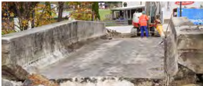
Die Bauarbeiten auf der Zehnthofer-Brücke sind bereits angelaufen. Noch vor Weihnachten soll die Brücke wieder befahrbar sein.
