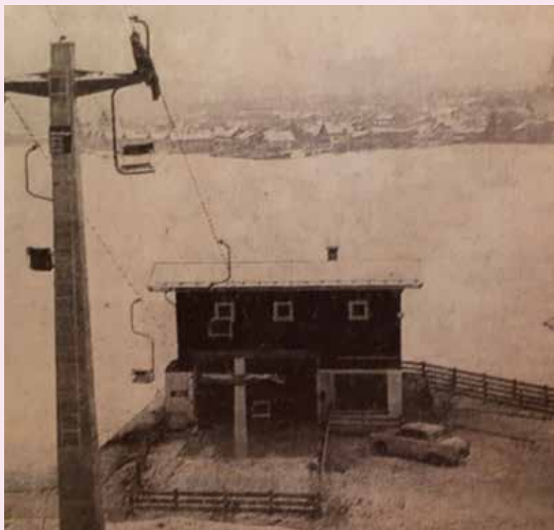
Die Talstation der Liftanlage Hennersberg.
