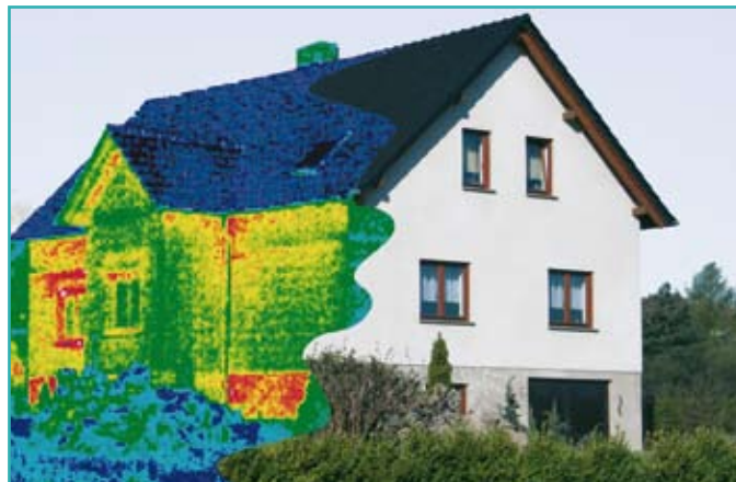
Die Thermografieaufnahme enthüllt die Schwachstellen eines Hauses.
