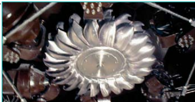
Turbinenrad Kraftwerk Kelchsau-Ehreit
